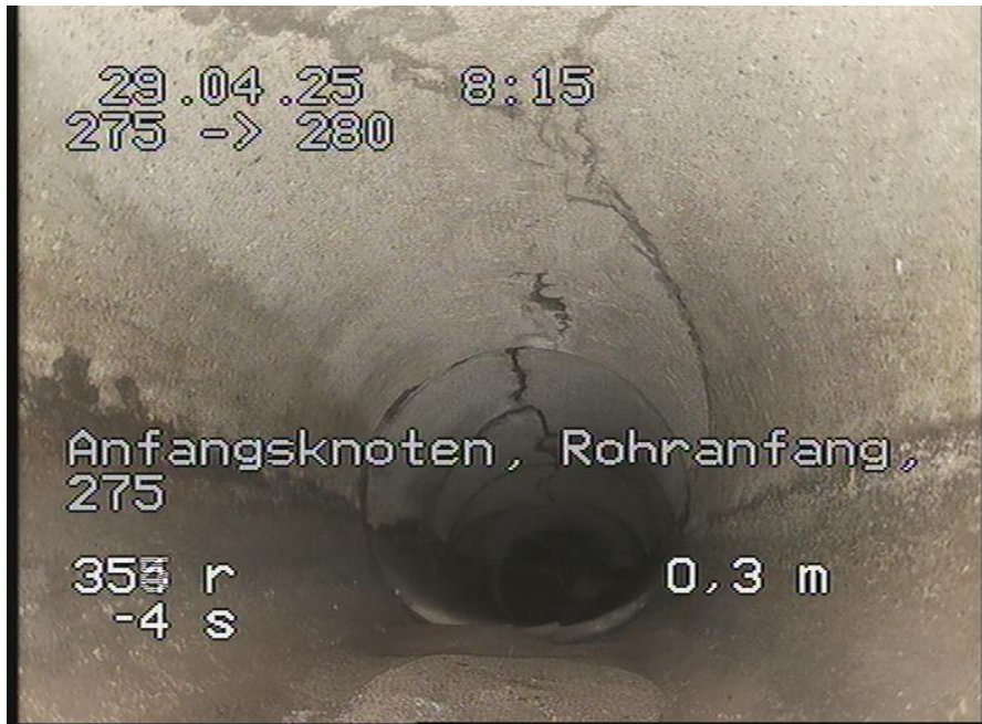
275-280_408.jpg, 00:00:00, 0.00m Anfangsknoten, Rohranfang, 275
