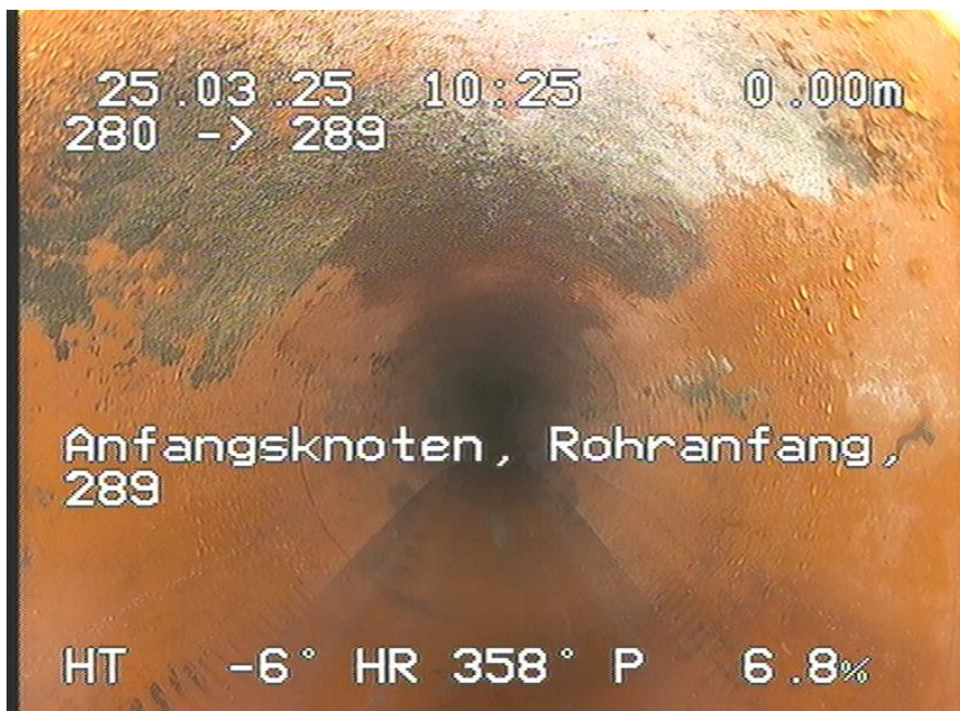
280-289_202.jpg, 00:00:00, 0.00m Anfangsknoten, Rohranfang, 289
