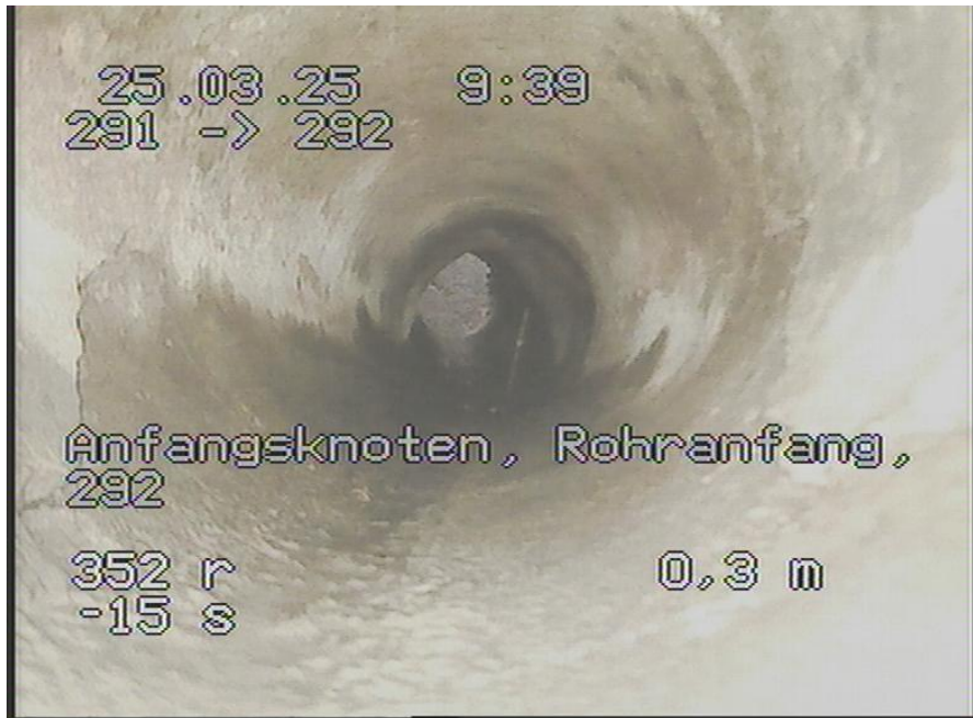
291-292_182.jpg, 00:00:00, 0.00m Anfangsknoten, Rohranfang, 292
