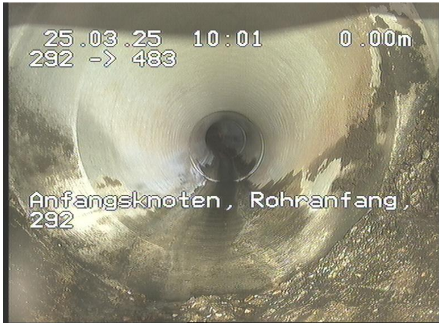
292-483_192.jpg, 00:00:00, 0.00m Anfangsknoten, Rohranfang, 292
