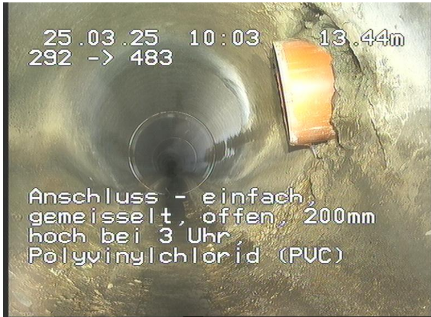
292-483_194.jpg, 00:01:23, 13.44m Anschluss - einfach, gemeisselt, offen, 250mm hoch bei 3 Uhr, Polyvinylchlorid (PVC)
