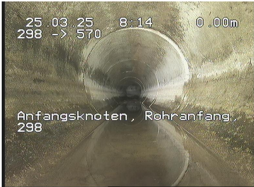
298-570_145.jpg, 00:00:00, 0.00m Anfangsknoten, Rohranfang, 298
