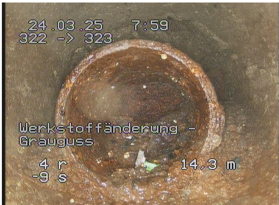
322-323_16.jpg, 00:01:28, 14.30m Werkstoffänderung - Grauguss
