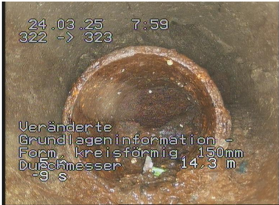
322-323_15.jpg, 00:01:24, 14.30m Veränderte Grundlageninformation - Form, kreisförmig, 150mm Durchmesser
