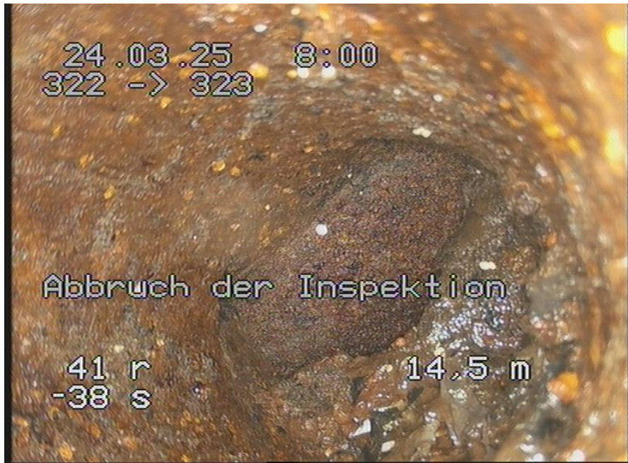
322-323_17.jpg, 00:01:49, 14.50m Abbruch der Inspektion / Gegenbefahrung nicht möglich / kein Schacht
