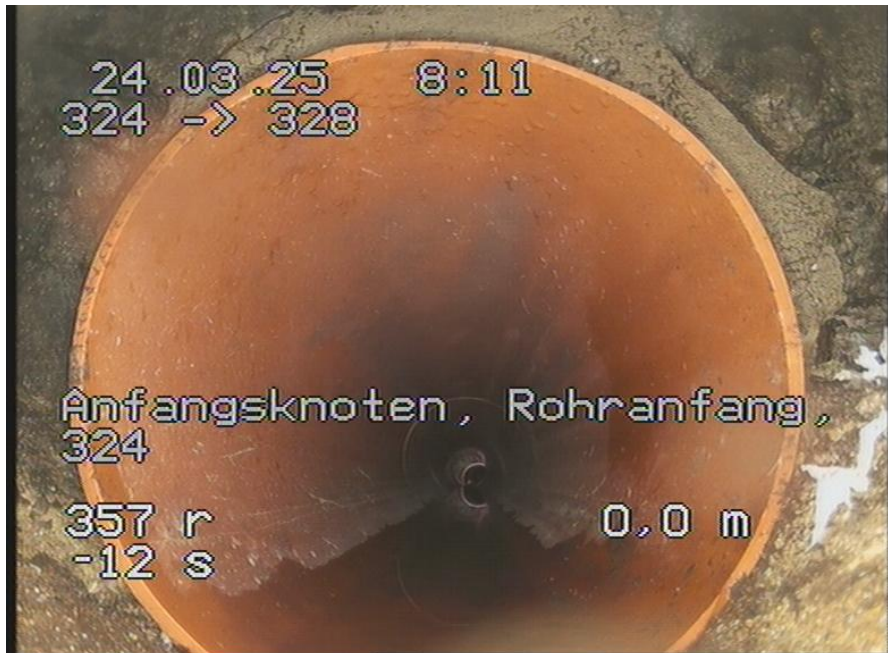
324-328_27.jpg, 00:00:00, 0.00m Anfangsknoten, Rohranfang, 324
