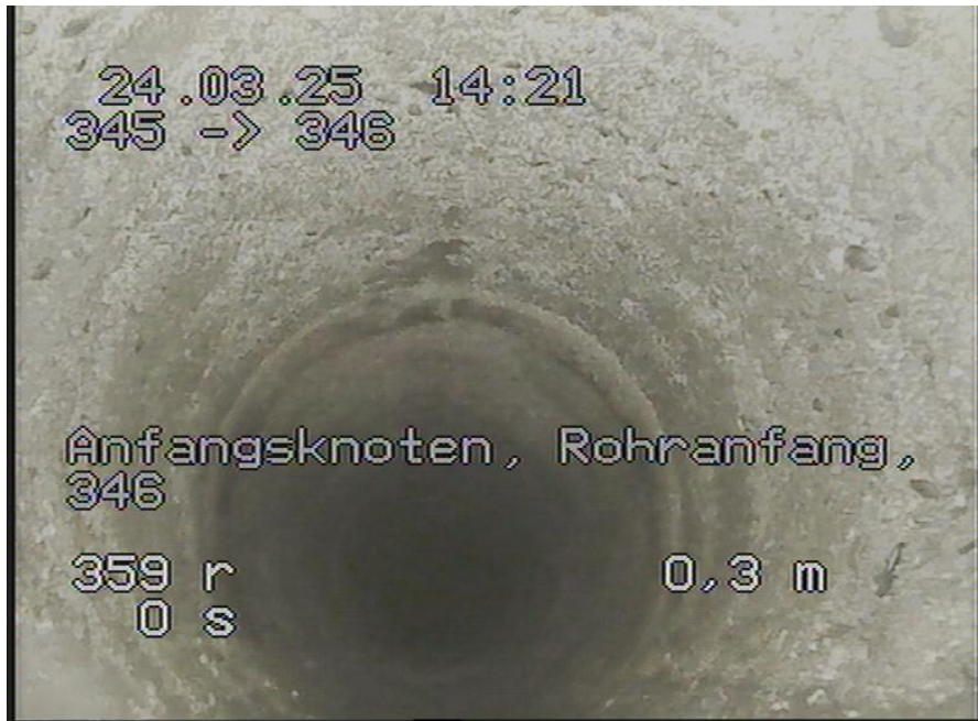
345-346_117.jpg, 00:00:00, 0.00m Anfangsknoten, Rohranfang, 346
