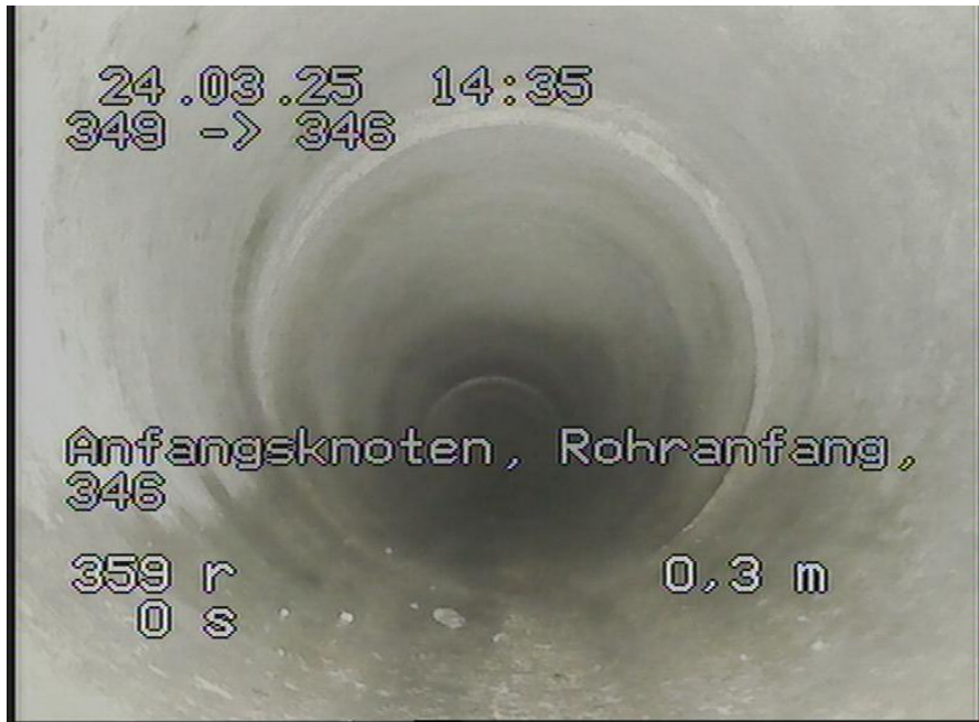
349-346_124.jpg, 00:00:00, 0.00m Anfangsknoten, Rohranfang, 346
