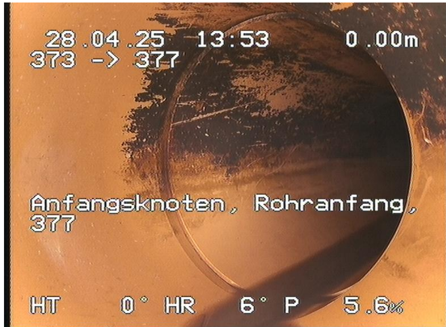
373-377_398.jpg, 00:00:00, 0.00m Anfangsknoten, Rohranfang, 377
