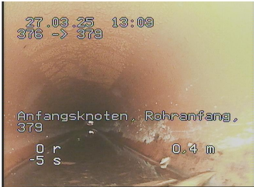
376-379_377.jpg, 00:00:00, 0.00m Anfangsknoten, Rohranfang, 379
