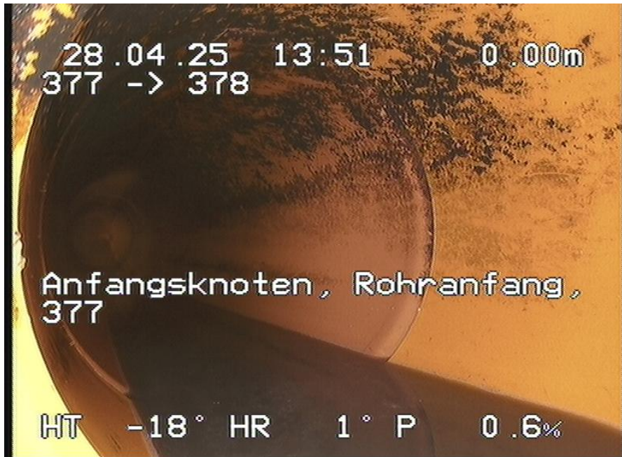
377-378_396.jpg, 00:00:00, 0.00m Anfangsknoten, Rohranfang, 377
