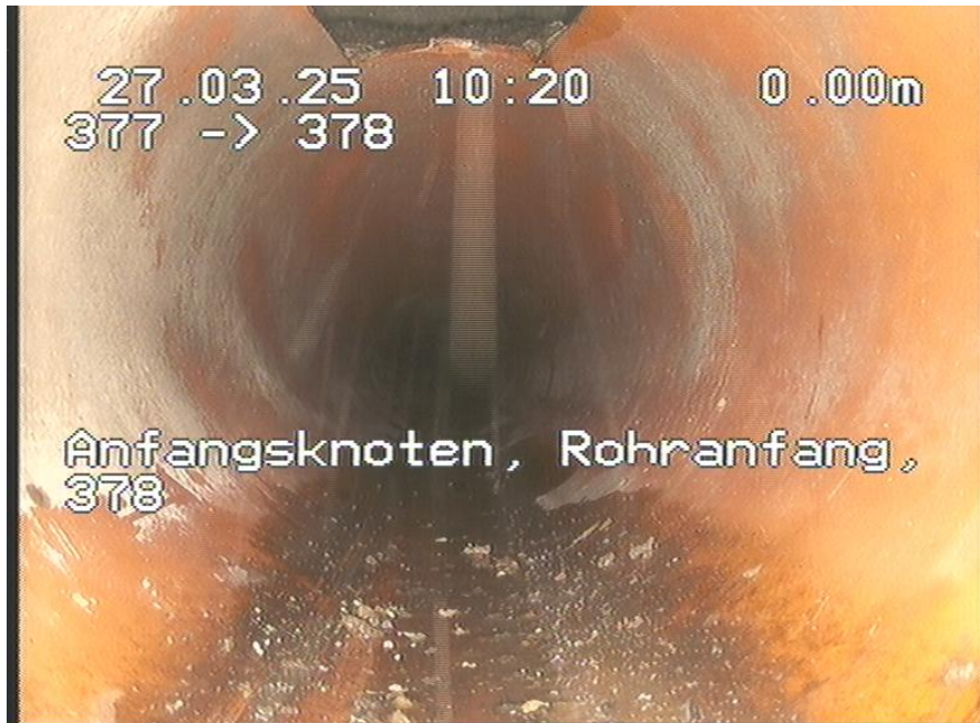
377-378_367.jpg, 00:00:00, 0.00m Anfangsknoten, Rohranfang, 378
