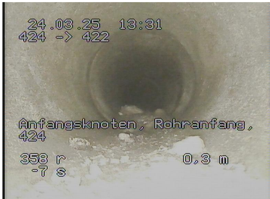
424-422_105.jpg, 00:00:00, 0.00m Anfangsknoten, Rohranfang, 424
