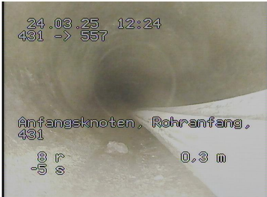
431-557_73.jpg, 00:00:00, 0.00m Anfangsknoten, Rohranfang, 431
