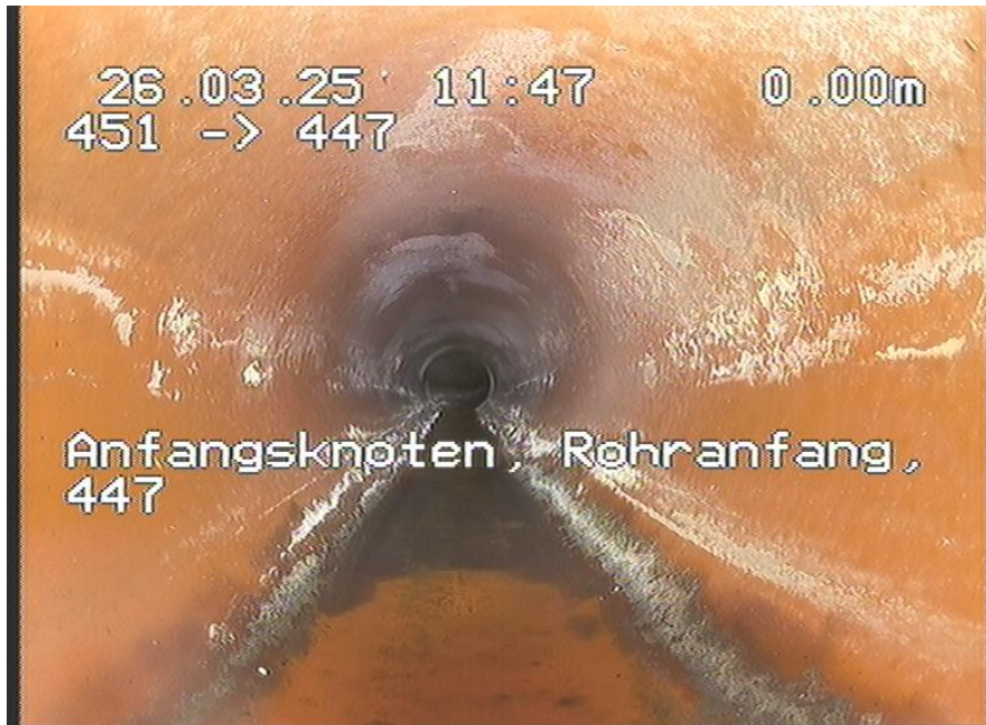
451-447_273.jpg, 00:00:00, 0.00m Anfangsknoten, Rohranfang, 447
