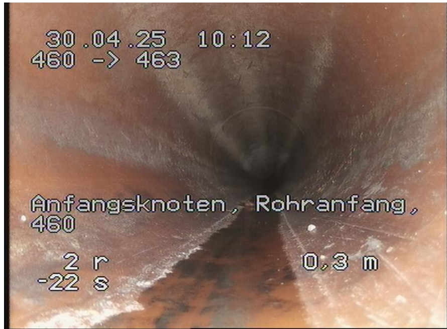
460-463_479.jpg, 00:00:00, 0.00m Anfangsknoten, Rohranfang, 460
