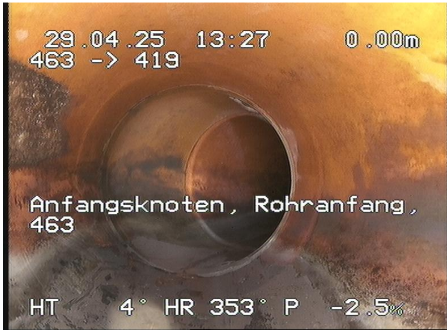
463-419_456.jpg, 00:00:00, 0.00m Anfangsknoten, Rohranfang, 463
