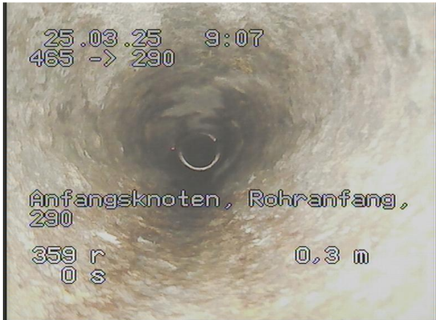
465-290_167.jpg, 00:00:00, 0.00m Anfangsknoten, Rohranfang, 290
