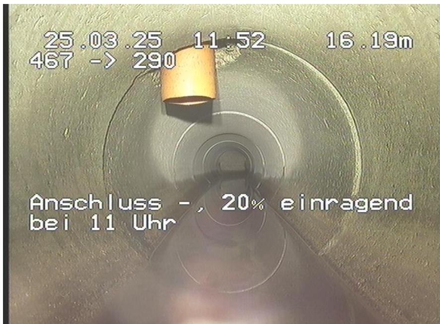
467-290_228.jpg, 00:01:15, 16.19m Anschluss -, 20% einragend bei 11 Uhr
