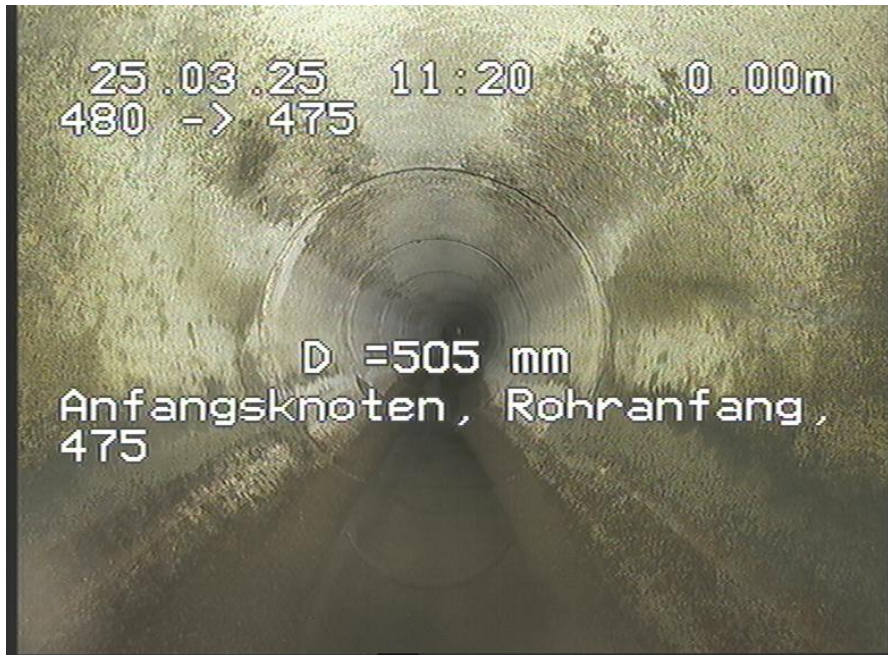
480-475_210.jpg, 00:00:00, 0.00m Anfangsknoten, Rohranfang, 475
