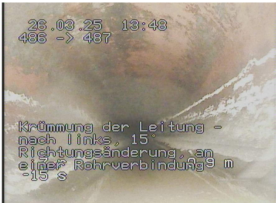
486-487_307.jpg, 00:00:24, 0.90m Krümmung der Leitung - nach links, 15° Richtungsänderung, an einer Rohrverbindung
