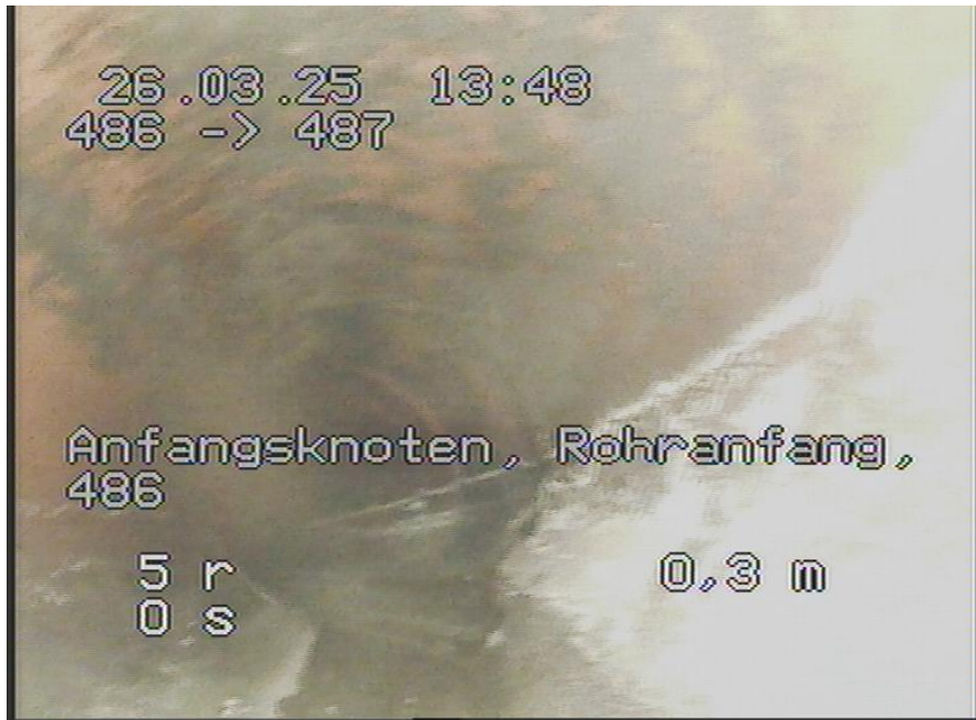
486-487_306.jpg, 00:00:00, 0.00m Anfangsknoten, Rohranfang, 486
