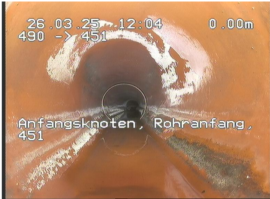
490-451_275.jpg, 00:00:00, 0.00m Anfangsknoten, Rohranfang, 451
