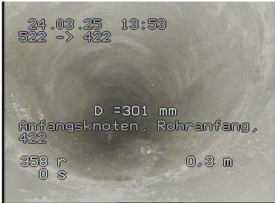
522-422_107.jpg, 00:00:00, 0.00m Anfangsknoten, Rohranfang, 422
