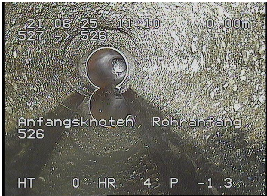
527-526_729.jpg, 00:00:00, 0.00m Anfangsknoten, Rohranfang, 526
