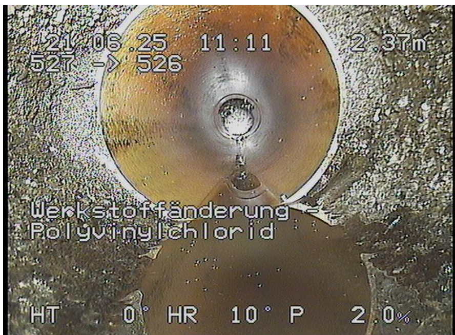
527-526_730.jpg, 00:00:29, 2.37m Werkstoffänderung - Polyvinylchlorid
