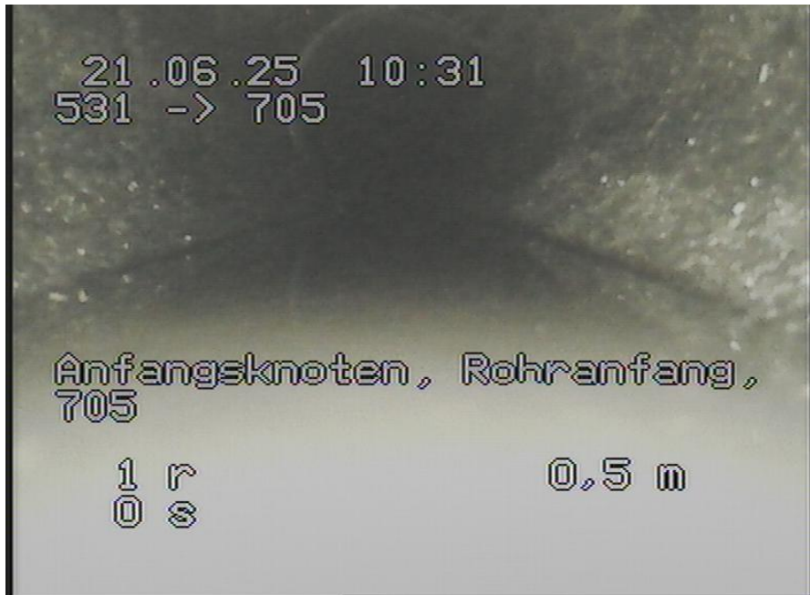
531-705_722.jpg, 00:00:00, 0.00m Anfangsknoten, Rohranfang, 705
