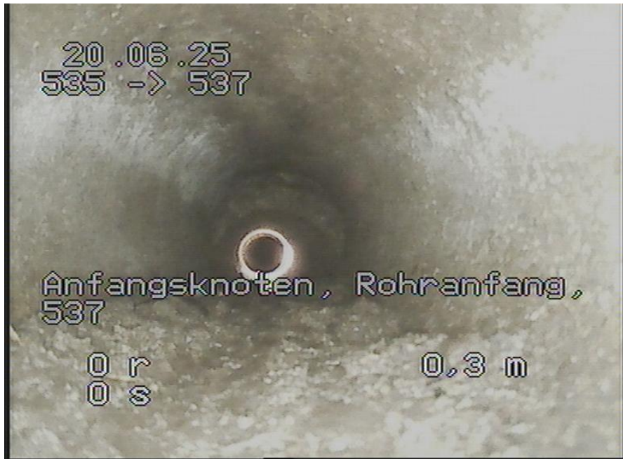
535-537_673.jpg, 00:00:00, 0.00m Anfangsknoten, Rohranfang, 537
