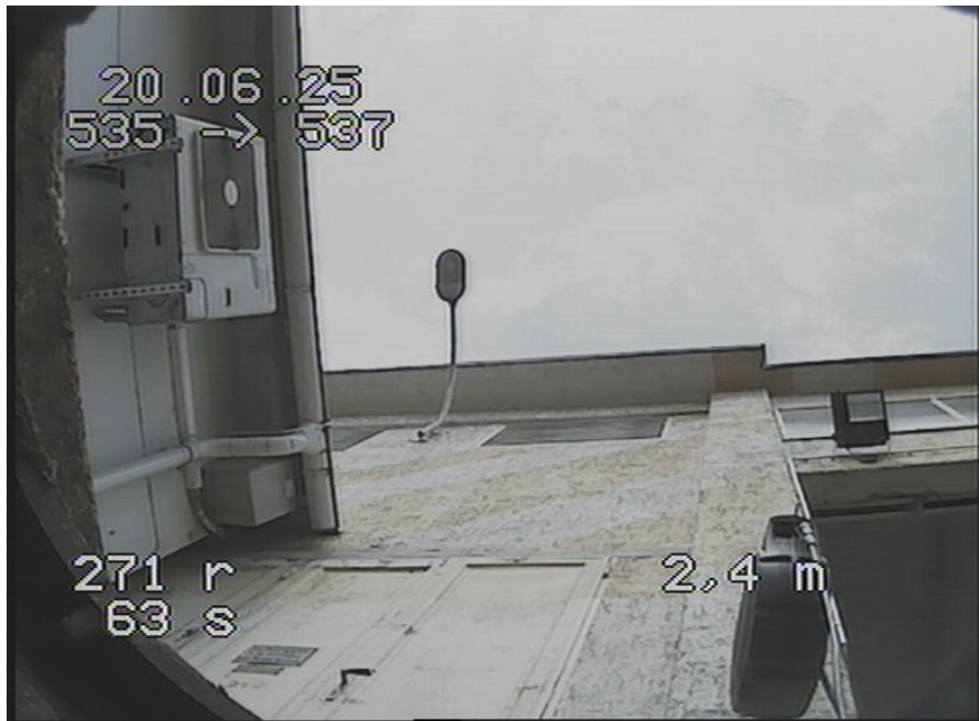
535-537_676.jpg, 00:00:40, 2.40m Endknoten, Rohrende, 535
