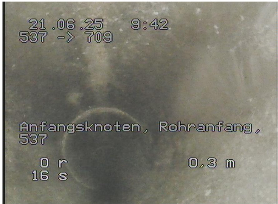
537-709_707.jpg, 00:00:00, 0.00m Anfangsknoten, Rohranfang, 537
