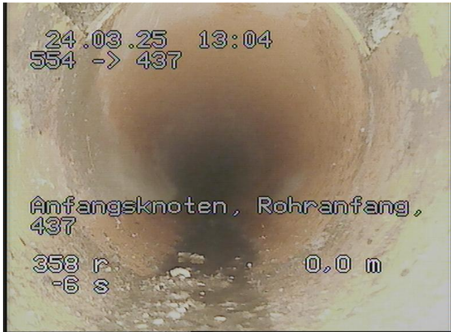
554-437_96.jpg, 00:00:00, 0.00m Anfangsknoten, Rohranfang, 437
