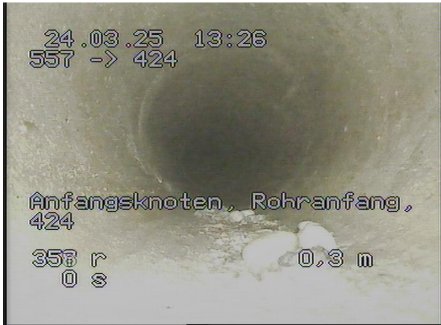
557-424_101.jpg, 00:00:00, 0.00m Anfangsknoten, Rohranfang, 424
