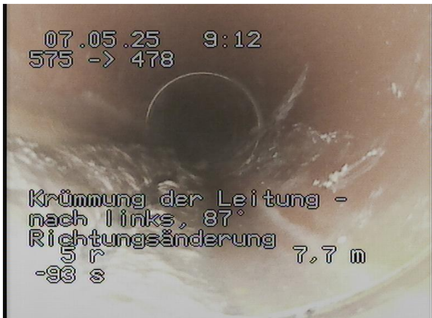
575-478_574.jpg, 00:02:05, 7.80m Krümmung der Leitung - nach links, 87° Richtungsänderung
