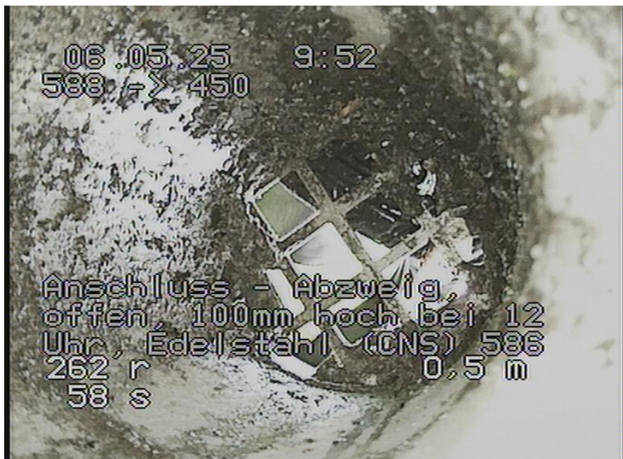
588-450_536.jpg, 00:00:19, 0.50m Anschluss - Abzweig, offen, 100mm hoch bei 12 Uhr, Edelstahl (CNS) / 586
