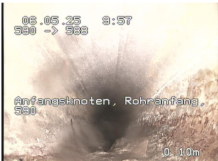
590-588_539.jpg, 00:00:00, 0.00m Anfangsknoten, Rohranfang, 590
