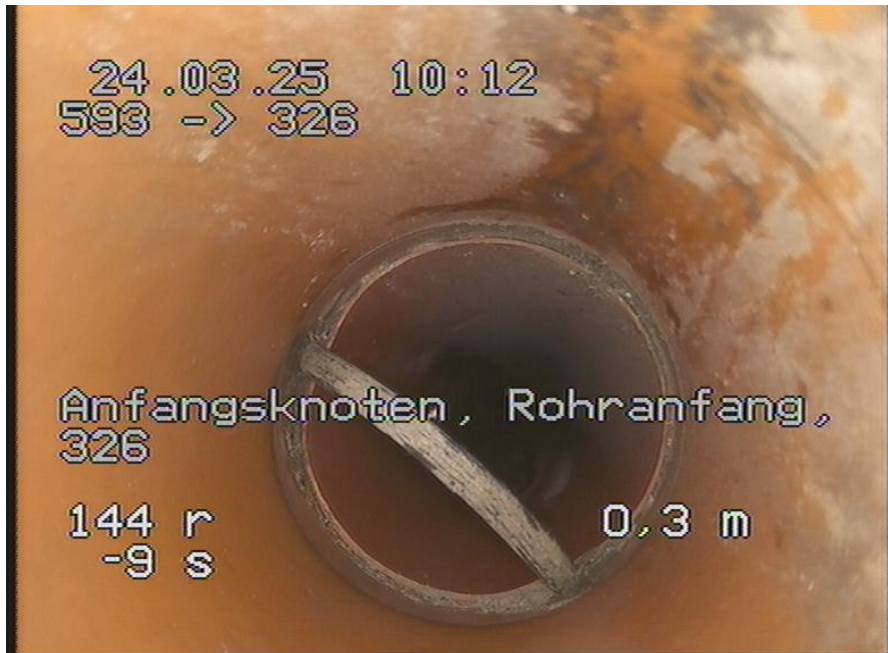
593-326_40.jpg, 00:00:00, 0.00m Anfangsknoten, Rohranfang, 326
