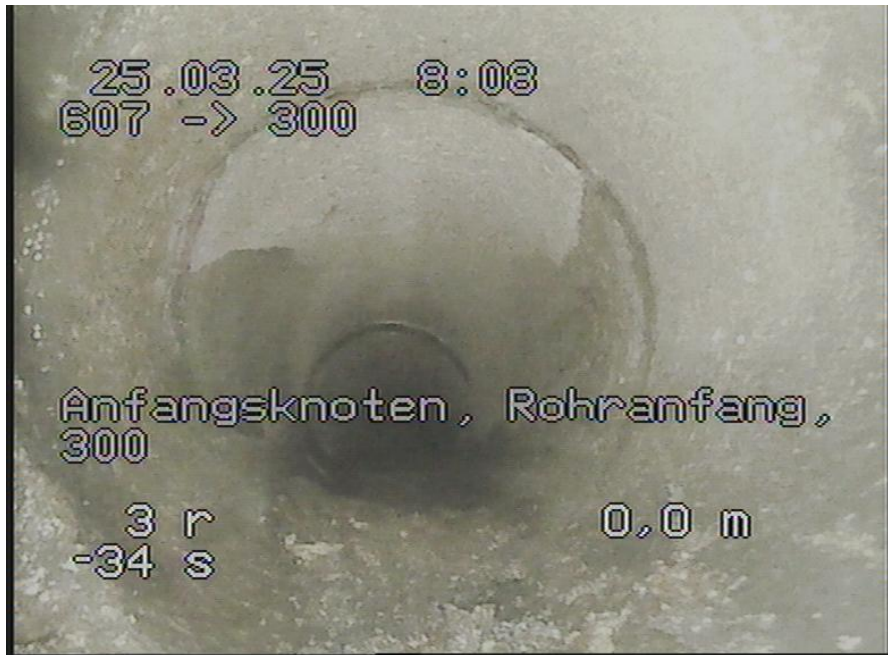
607-300_139.jpg, 00:00:00, 0.00m Anfangsknoten, Rohranfang, 300
