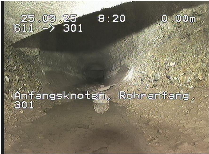
611-301_149.jpg, 00:00:00, 0.00m Anfangsknoten, Rohranfang, 301
