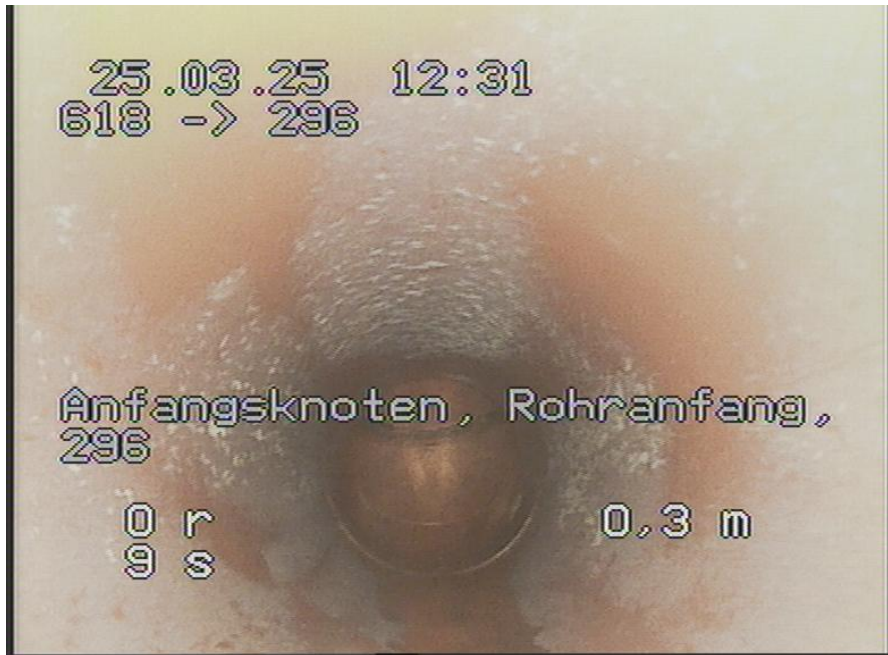
618-296_238.jpg, 00:00:00, 0.00m Anfangsknoten, Rohranfang, 296
