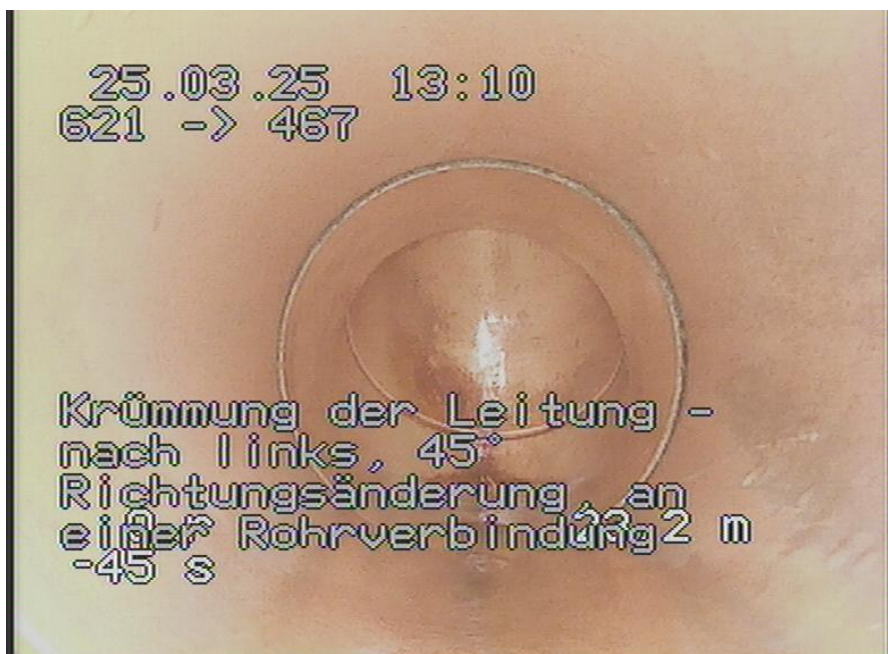
621-467_251.jpg, 00:01:34, 23.20m Krümmung der Leitung - nach links, 45° Richtungsänderung, an einer Rohrverbindung
