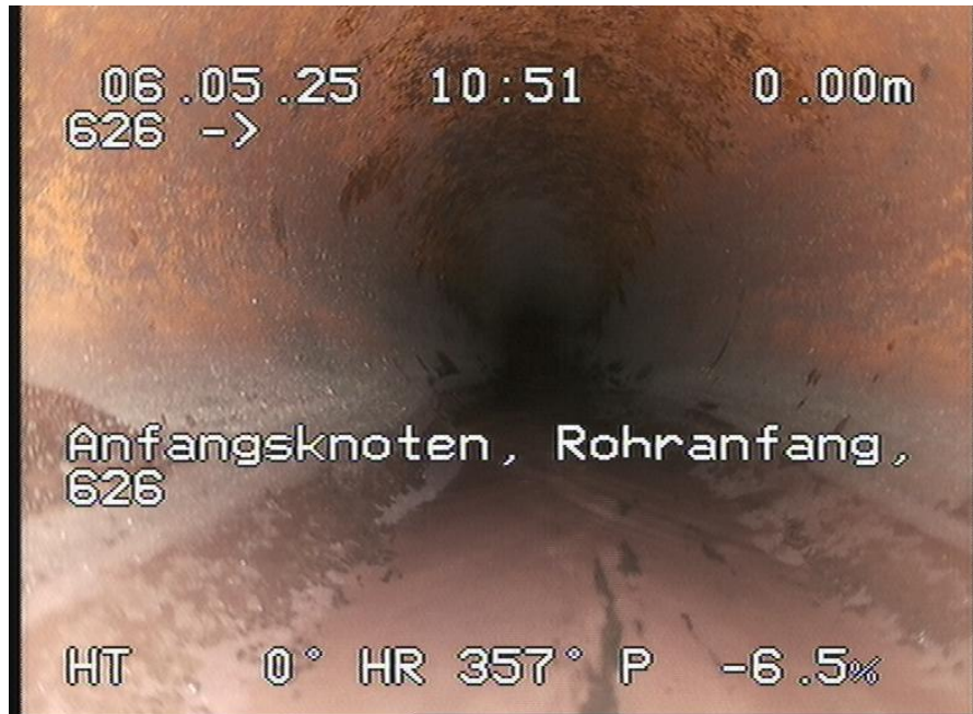
626- 552.jpg, 00:00:00, 0.00m Anfangsknoten, Rohranfang, 626
