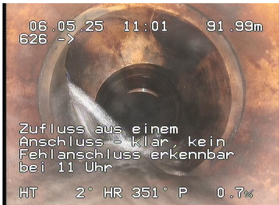
626- 555.jpg, 00:08:56, 91.99m Zufluss aus einem Anschluss - klar, kein Fehlanschluss erkennbar bei 11 Uhr
