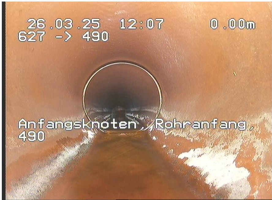
627-490_277.jpg, 00:00:00, 0.00m Anfangsknoten, Rohranfang, 490
