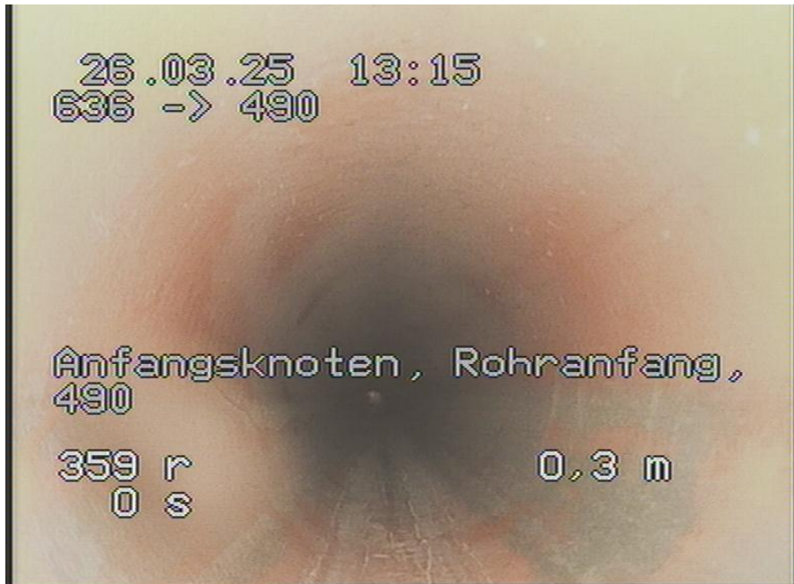
636-490_293.jpg, 00:00:00, 0.00m Anfangsknoten, Rohranfang, 490
