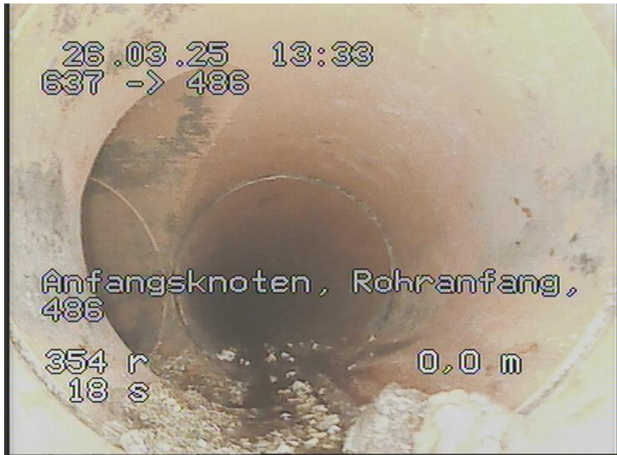
637-486_295.jpg, 00:00:00, 0.00m Anfangsknoten, Rohranfang, 486
