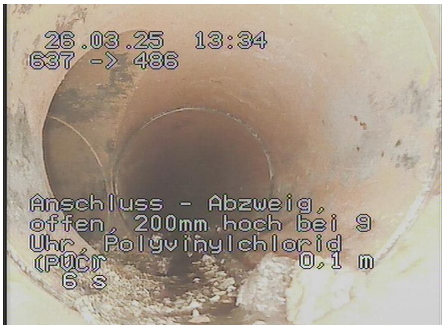
637-486_296.jpg, 00:00:15, 0.20m Anschluss - Abzweig, offen, 200mm hoch bei 9 Uhr, Polyvinylchlorid (PVC)
