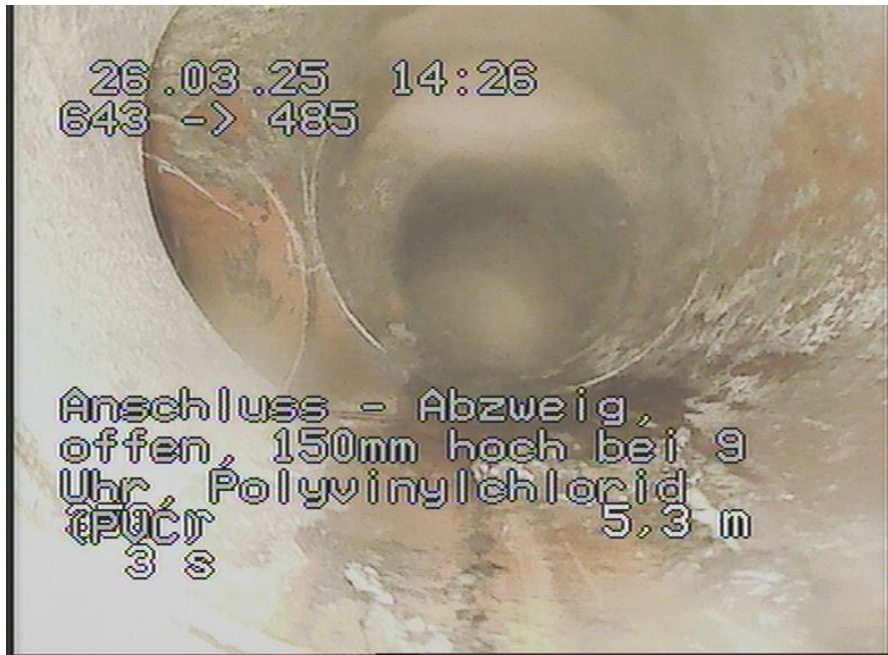
643-485_320.jpg, 00:01:51, 5.30m Anschluss - Abzweig, offen, 150mm hoch bei 9 Uhr, Polyvinylchlorid (PVC)
