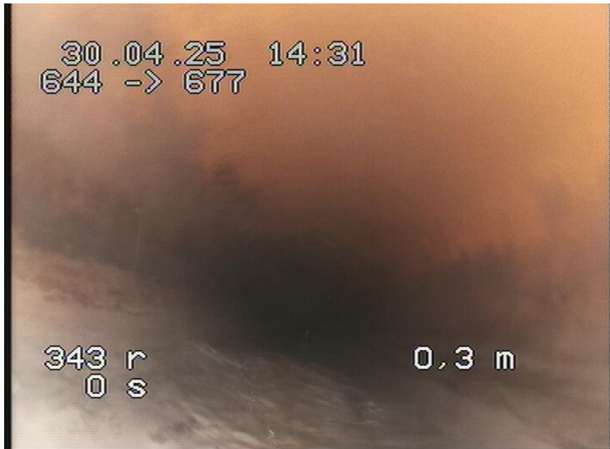
644-677_521.jpg, 00:00:00, 0.00m Anfangsknoten, Rohranfang, 644
