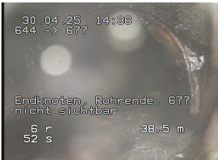
644-677_522.jpg, 00:04:54, 38.50m Endknoten, Rohrende, 677 / nicht sichtbar
