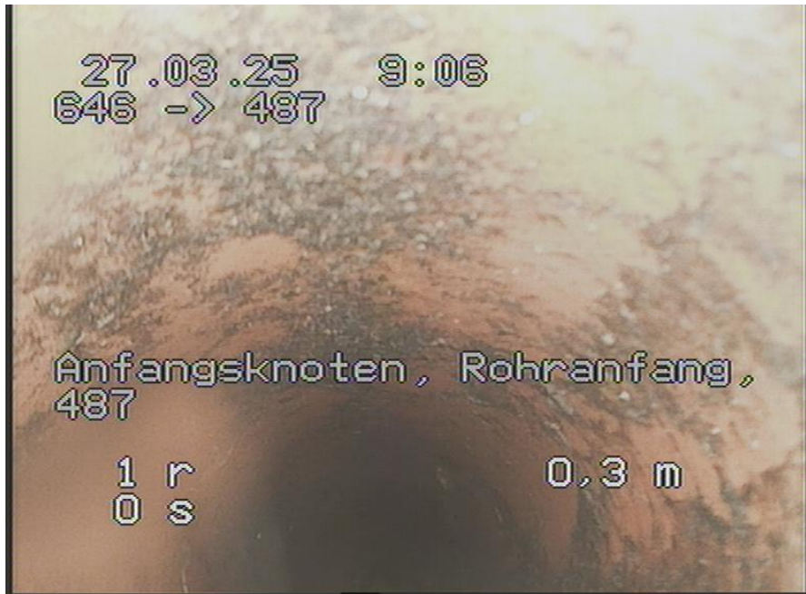
646-487_349.jpg, 00:00:00, 0.00m Anfangsknoten, Rohranfang, 487
