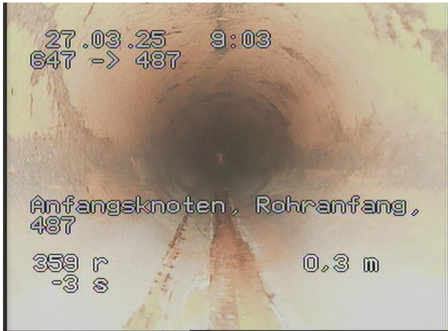
647-487_347.jpg, 00:00:00, 0.00m Anfangsknoten, Rohranfang, 487
