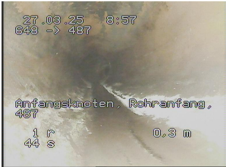
648-487_337.jpg, 00:00:00, 0.00m Anfangsknoten, Rohranfang, 487
