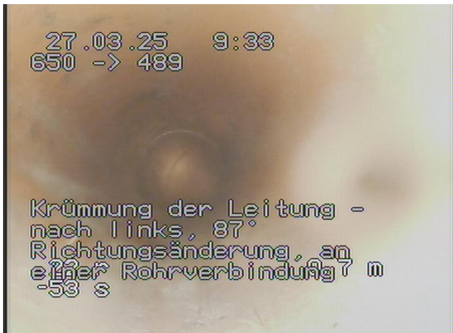
650-489_359.jpg, 00:00:22, 0.70m Krümmung der Leitung - nach links, 87° Richtungsänderung, an einer Rohrverbindung
