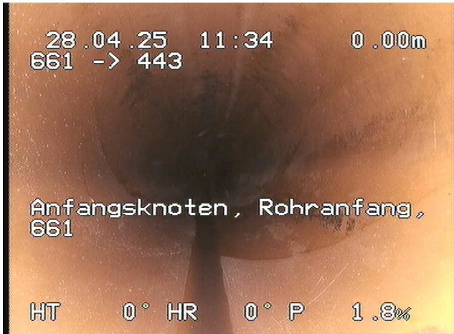
661-443_391.jpg, 00:00:00, 0.00m Anfangsknoten, Rohranfang, 661
