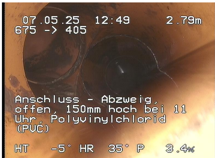
675-405_605.jpg, 00:00:29, 2.79m Anschluss - Abzweig, offen, 150mm hoch bei 11 Uhr, Polyvinylchlorid (PVC)
