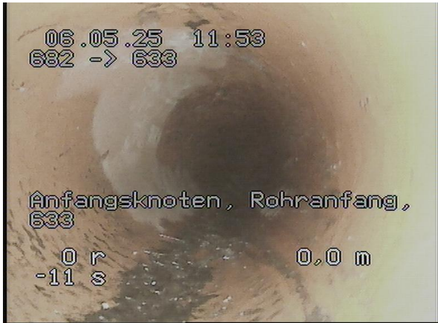
682-633_569.jpg, 00:00:00, 0.00m Anfangsknoten, Rohranfang, 633
