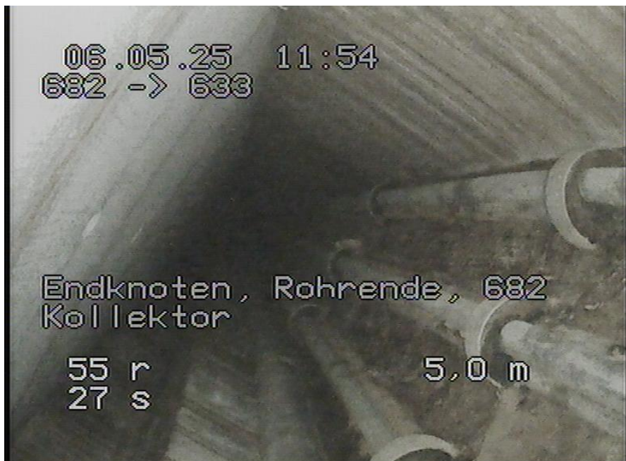
682-633_570.jpg, 00:00:47, 5.00m Endknoten, Rohrende, 682 / Kollektor
